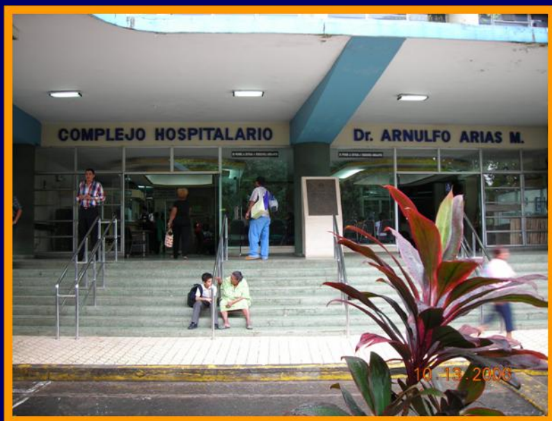
Arnulfo Hospital Complex, Caja de Seguro Social
